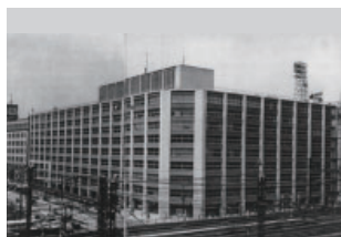
新大手町ビル 冷暖房設備
