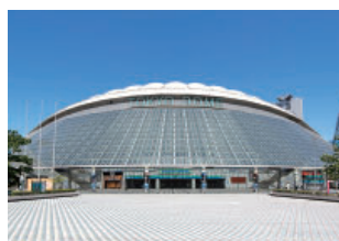
東京ドーム 空調設備
