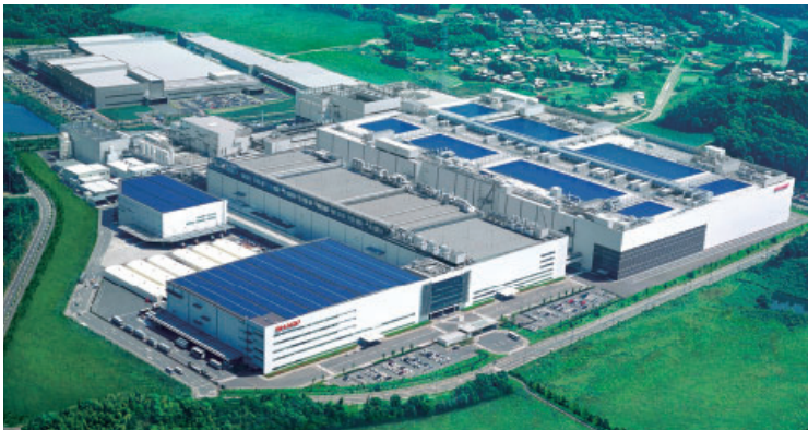
シャープ株式会社亀山工場 (三重県亀山市)
