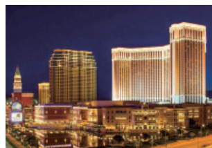
ザ・ヴェネチアン®・マカオ・リゾート・ホテル 空調・地域冷房設備(マカオ)
