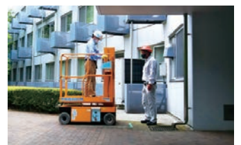
高所作業車運転教育
