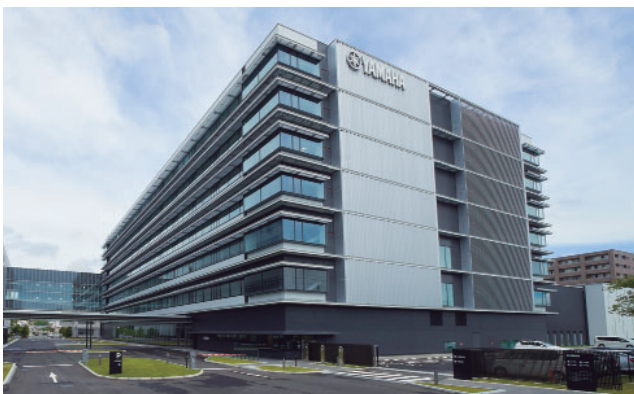
ヤマハ株式会社本社21号館 (静岡県浜松市)
