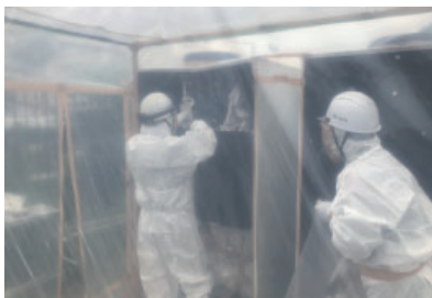
RCF含有製品の撤去作業
