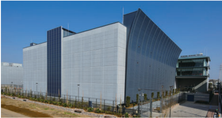
NTT DATA 三鷹ビルEAST (東京都三鷹市)
