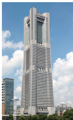
横浜ランドマークタワー 空調設備
