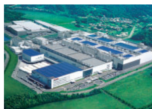
シャープ株式会社亀山工場 空調設備
